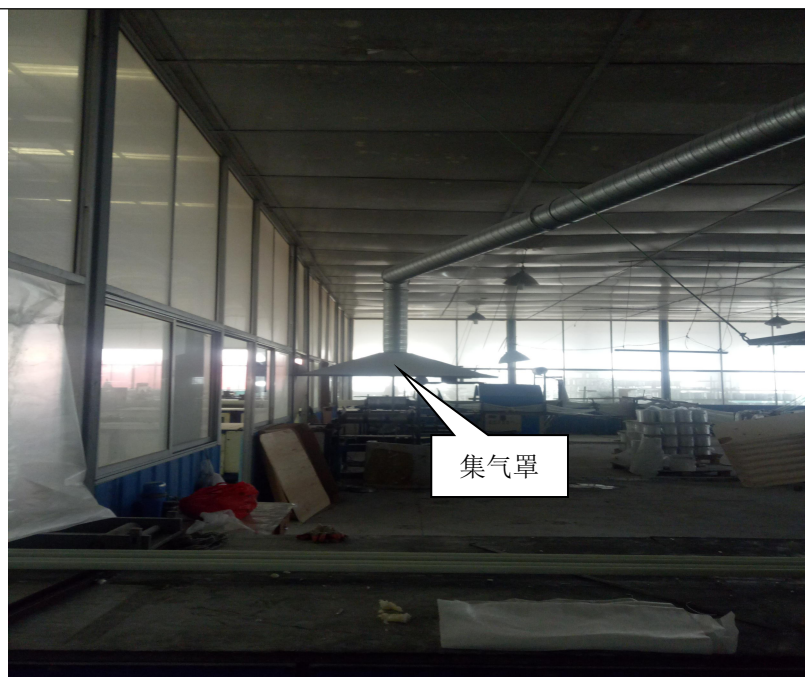
图 3-2 有机废气收集集气罩
