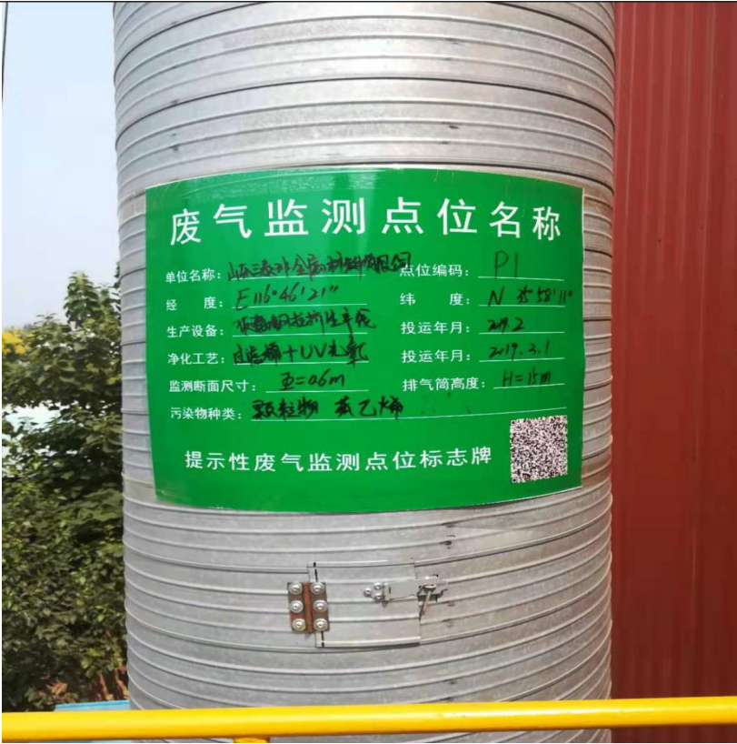
图 3-6 排气筒及采样孔
