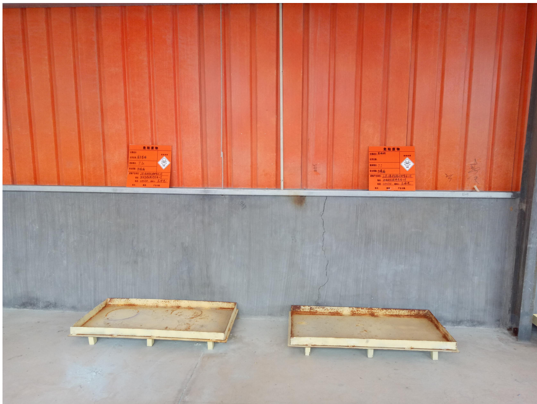
图 3-7 危险废物风险防范设施
