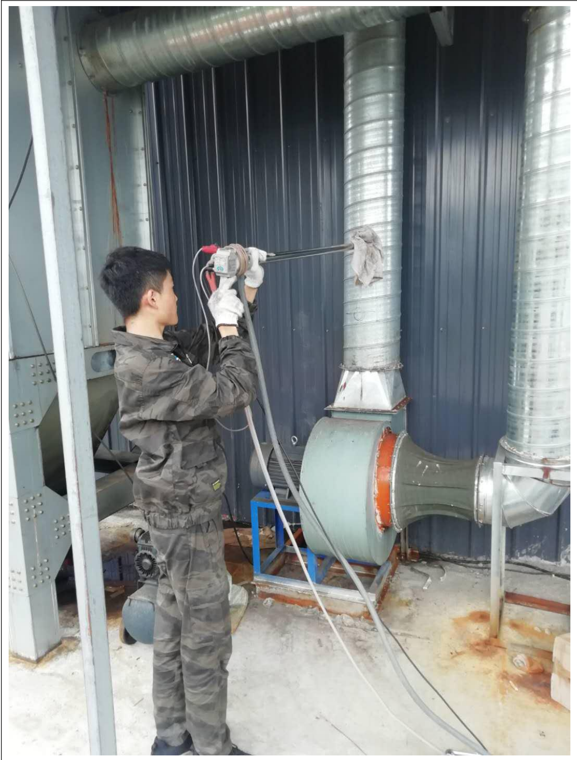
附件九 现场检测照片
