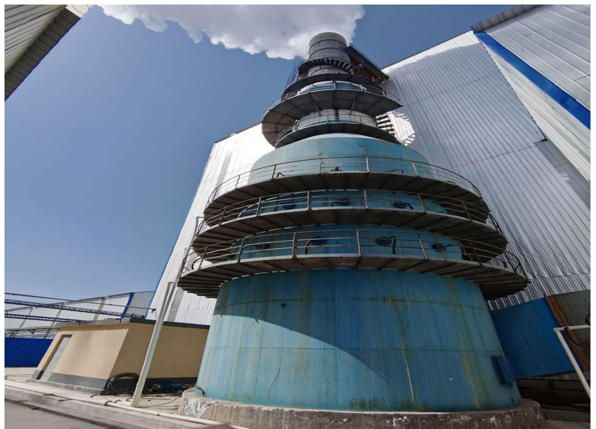
喷雾干燥塔：SNCR 脱硝+布袋除尘+双碱法脱硫
