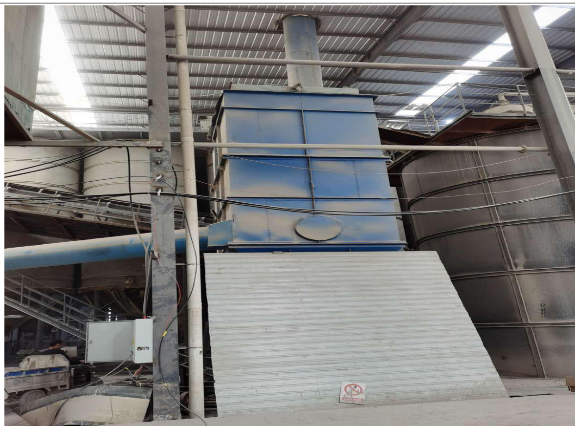
压制工序：袋式除尘器+15m 高的排气筒
