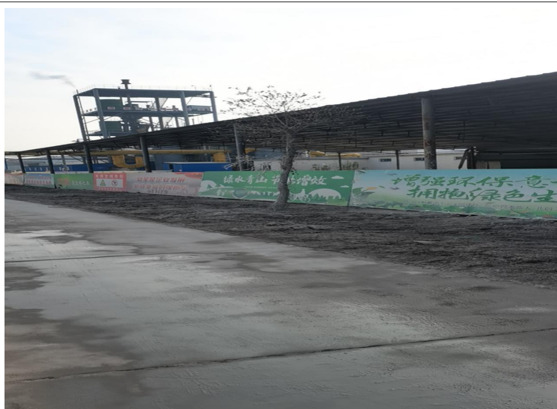
加高了打磨抛光沉淀池围堰
