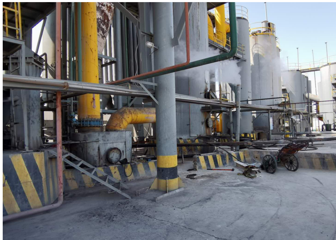
酚水输送管架空铺设
