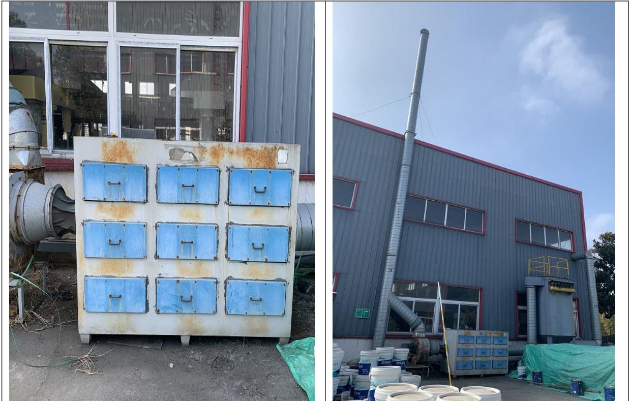
投料、研磨分散、调和调色、过滤、包装：布袋除尘器+二级活性炭吸附装置+15m 高排气筒（DA001）
