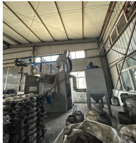
喷砂工序处理设施：滤芯除尘器+15m 排气筒
