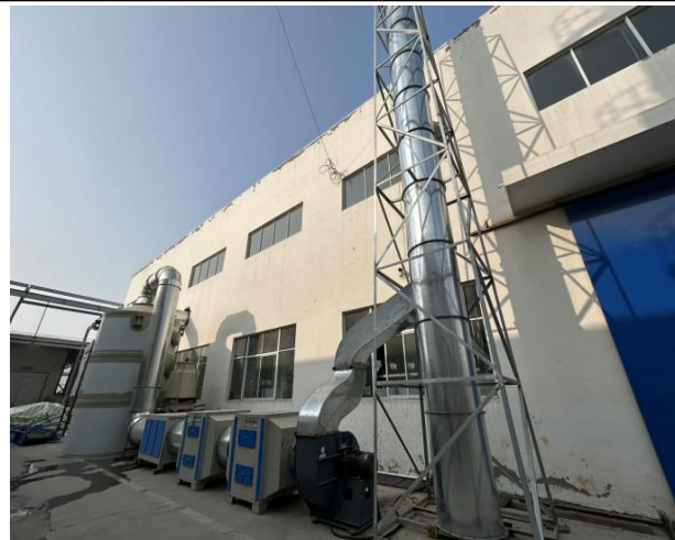
熔融挤出工序水喷淋+干燥箱+UV 光氧催化+活性炭
