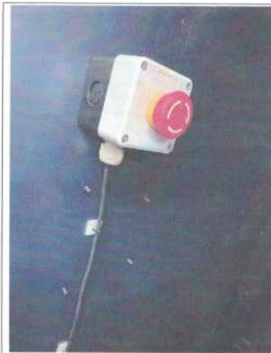
图 1 装载门左侧增设的急停按钮
