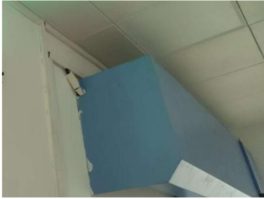
图 3-3.1 防护门门机联锁装置
