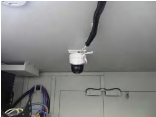
图 3-3.3 工业 CT 内部监控摄像头
