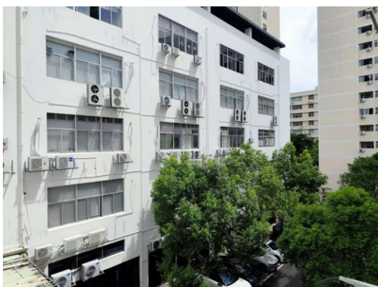
南侧园区道路
