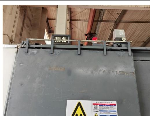
图 3-7 探伤室顶部“预备”指示灯
