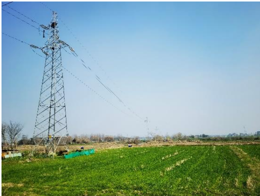
(a) 现有线路架设情况
