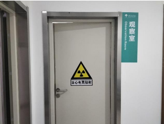
图 3-12 观察室（含电离辐射警告标志）
