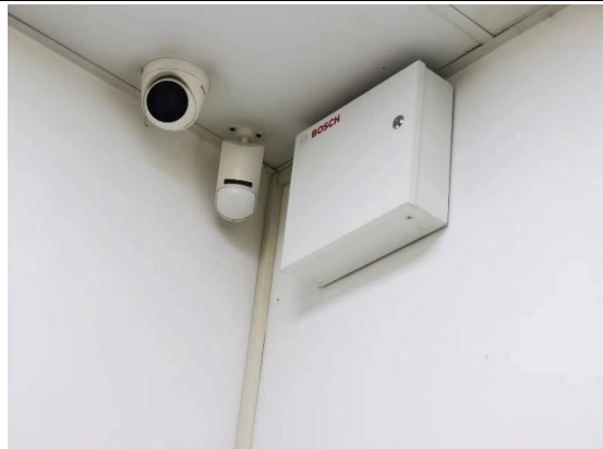
图 3-31 储源库内红外报警装置
