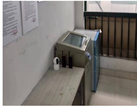
图 2 设备贮存间门口设置监控
