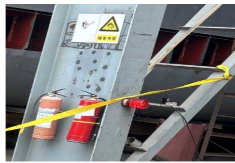
图 8 监督区设置声光报警装置
