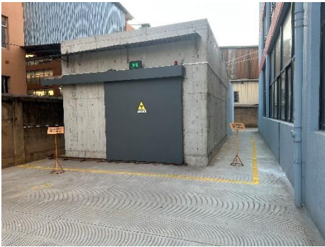
图 9 探伤室外设置 1m 警戒线
