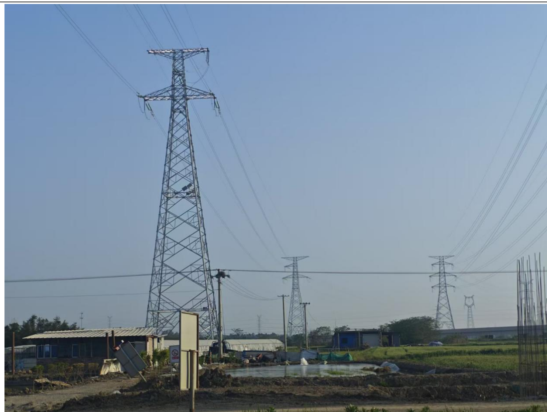
图 6-4 跃方 2437 线架空线路周边环境绿化恢复情况
