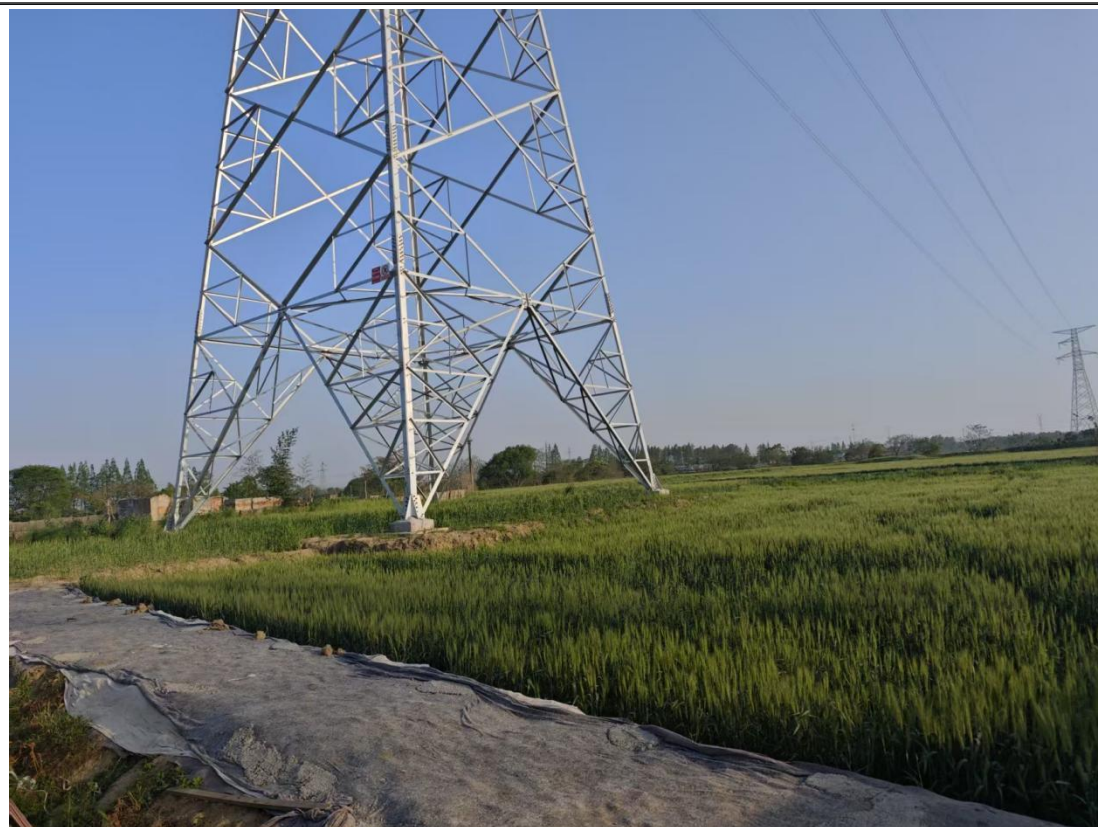
图 6-1 立跃 2404 立新 2405 线塔基周边环境绿化恢复情况
