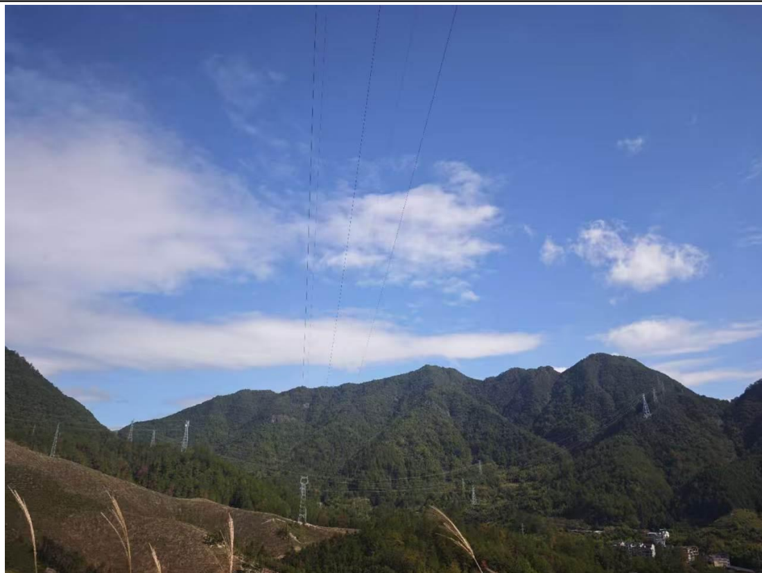
图 6-3 架空线路周边环境绿化恢复情况
