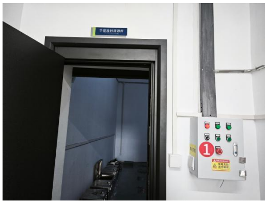
图 7 放射源暂存库开门装置
