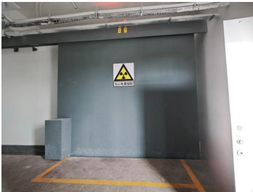
图 8 探伤室工件进出门安全警戒线、防护门 电离辐射警告标志、工作状态指示灯
