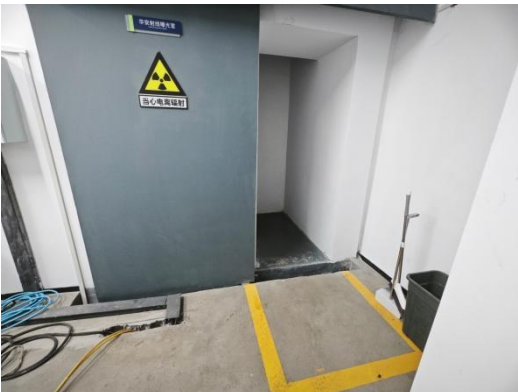
图 9 探伤室人员进出门安全警戒线、防护 门电离辐射警告标志
