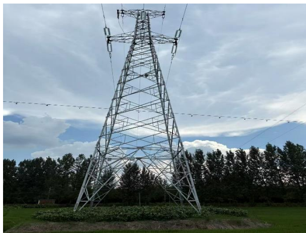
图 3-2 现有线路架设情况及塔基恢复情况
