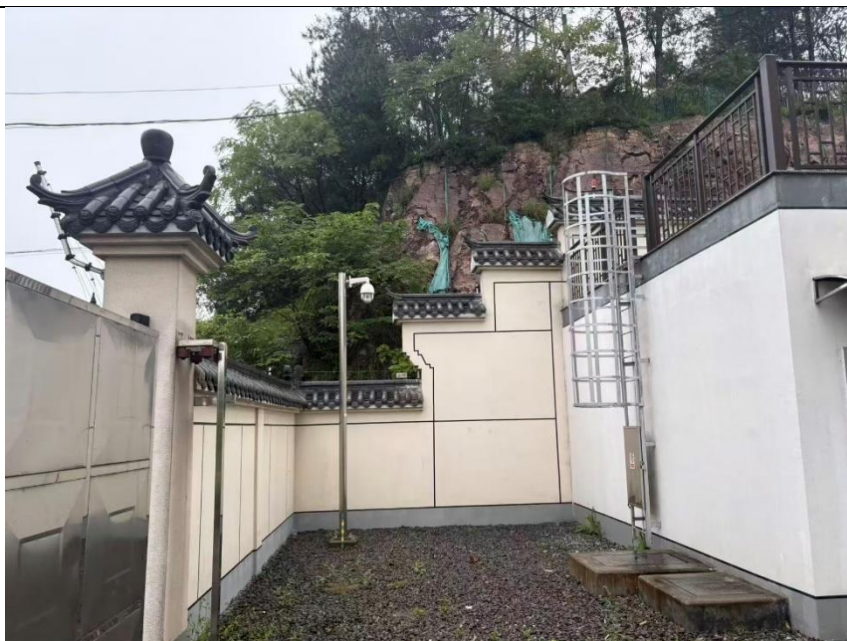
图 2-6 变电站北侧及东侧外山林
