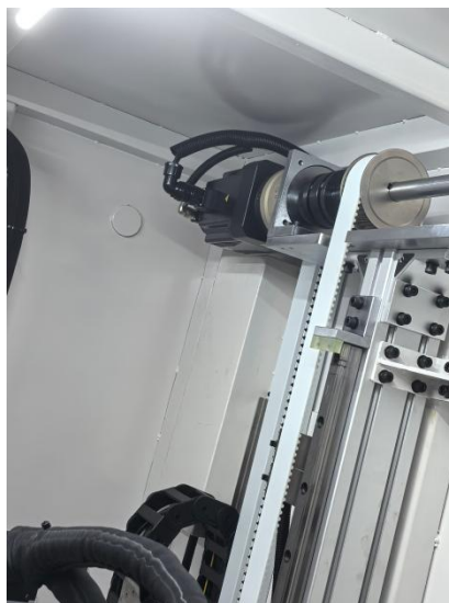
图 4 探伤铅房内部通风装置
