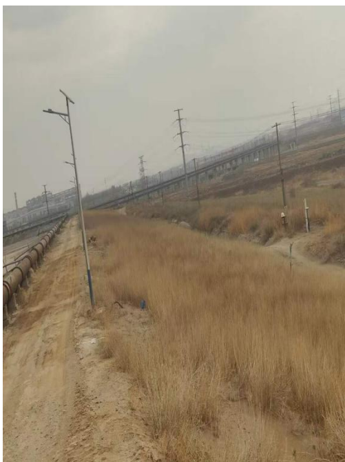
尾矿坝外坡照片
