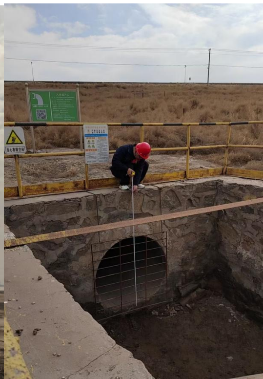
塔底涵管排水出口实测照片
