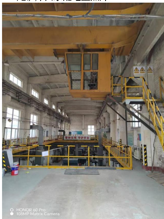
尾矿库回水泵室照片
