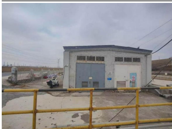
尾矿库回水配电室照片
