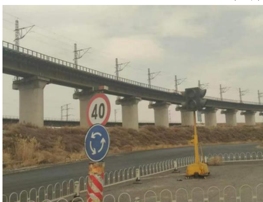
周边铁路照片
