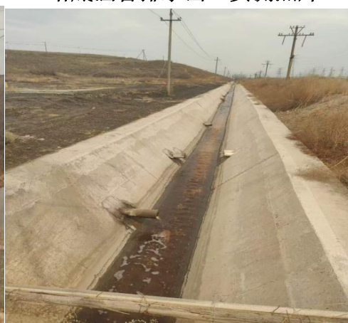
塔底涵管排水出口实测照片
