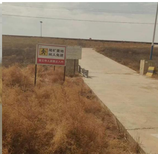
上坝道路及道口防护设施照片
