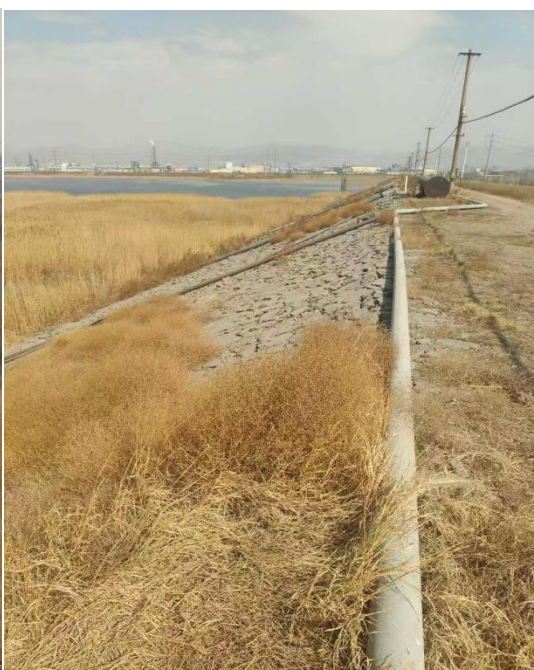
坝体内坡照片
