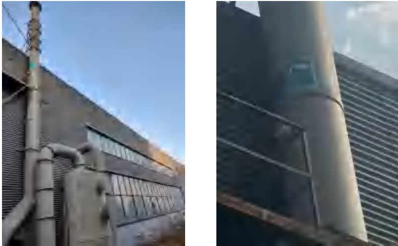
图 6 清洗废气排放口DA003及其检测口
