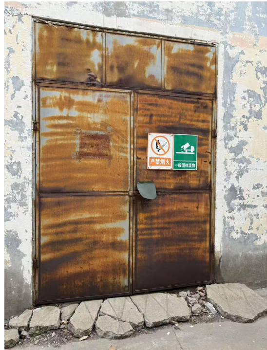
图 11 固废暂存间外部
