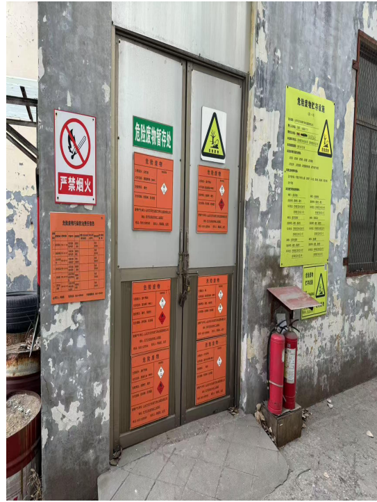
图 9 危废暂存间外部
