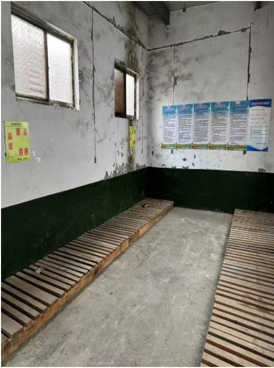
图 8 危废暂存间内部
