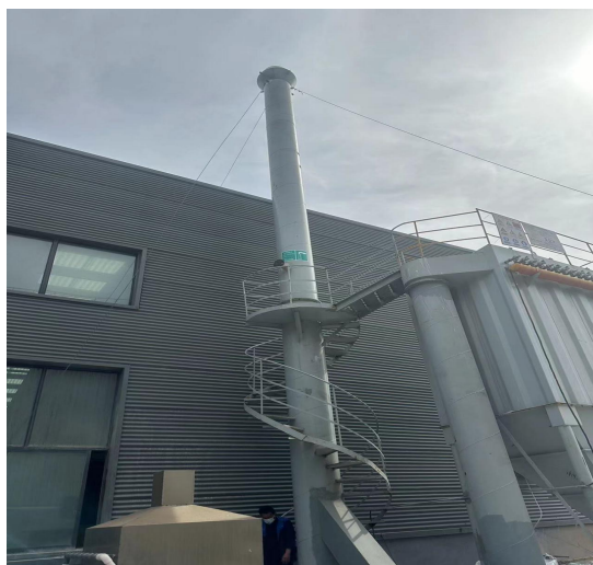
图 2 喷砂废气排气筒DA005及其检测口
