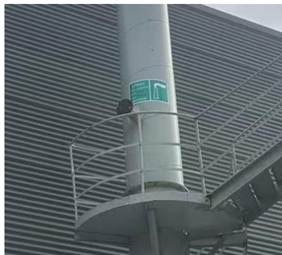
图 2 喷砂废气排气筒DA005及其检测口
