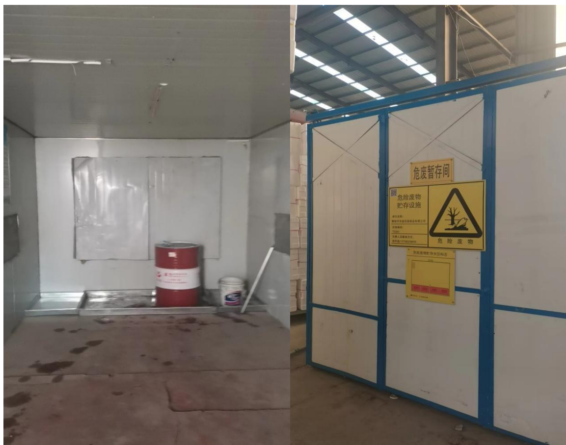
图 4 危废间内部照片
