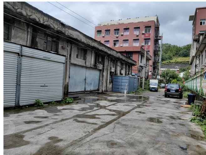
西南侧温州市东科汽车部件有限公司
