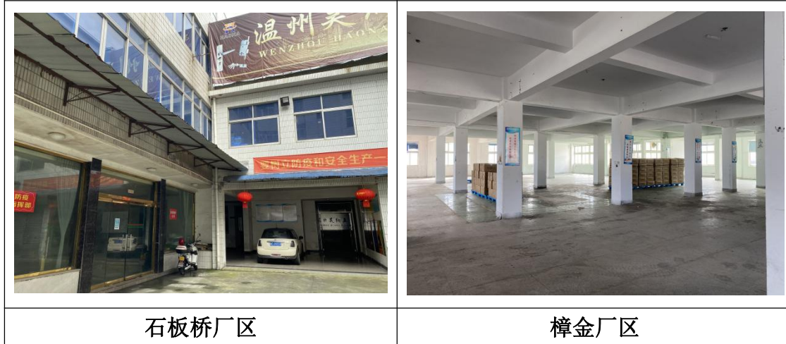
图 2-4 樟金厂区、石板桥厂区现状情况
