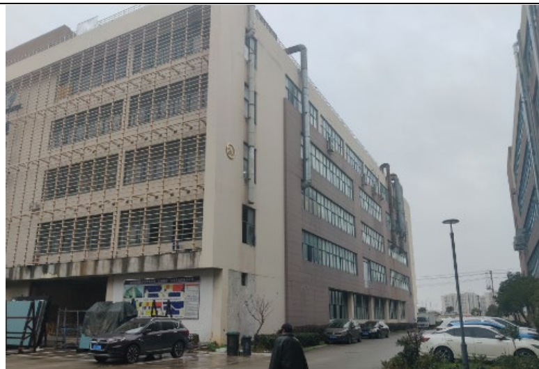
东南侧永兴南园 30 幢厂房
