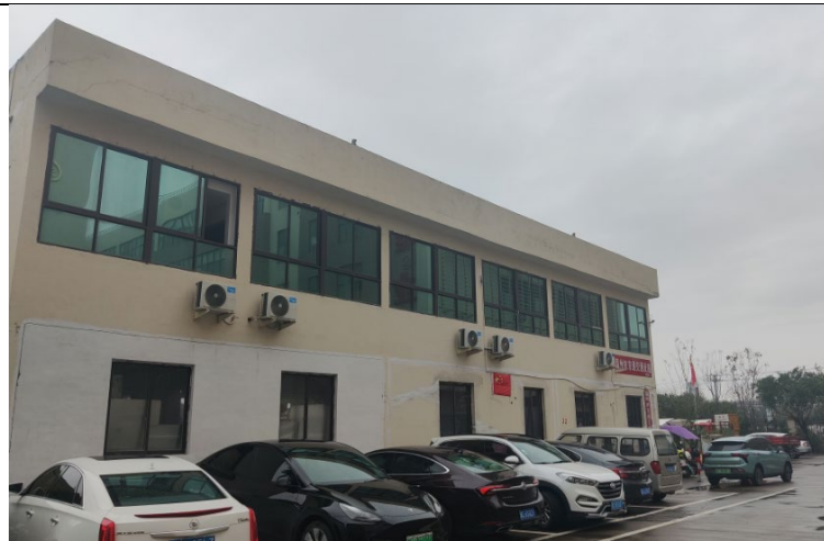
西北侧配电房及空地
