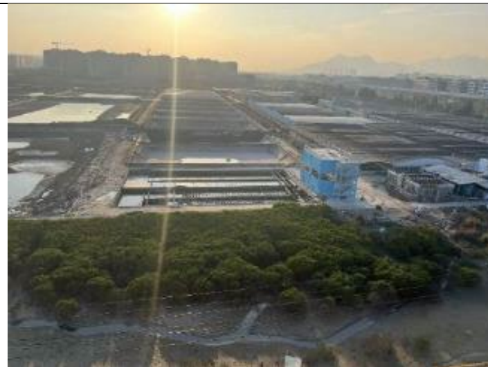
西南侧海洋养殖基地
