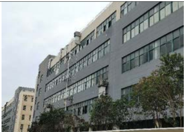
西南侧永兴南园厂房
