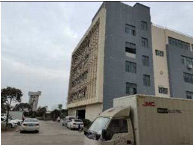
东北侧永兴南园厂房
