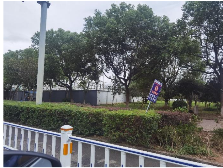
西北侧：高压线走廊、变电所
