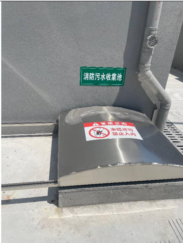
消防污水收集池（事故应急池）
