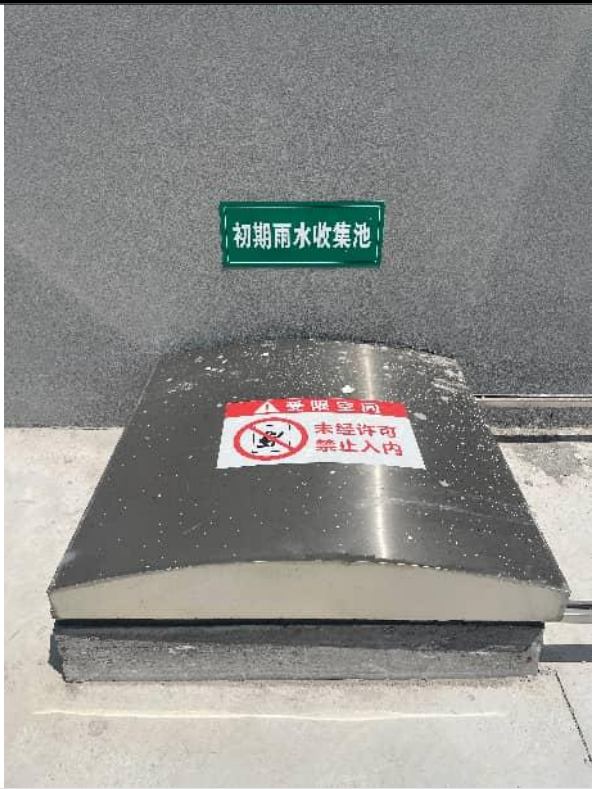
初期雨水收集池
